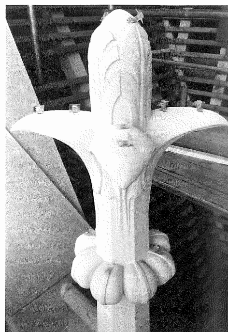
Un élément des sculptures refait à l'identique: un fleuron à la base du rampant d'un gâble.
